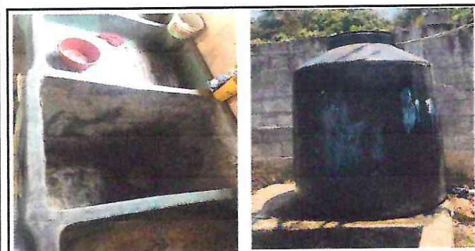
Foto 5: CAMBIO DE PILA Y TINACO POR FUGA
