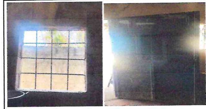
FOTO 4: CAMBIO DE VENTANAS Y PUERTA
