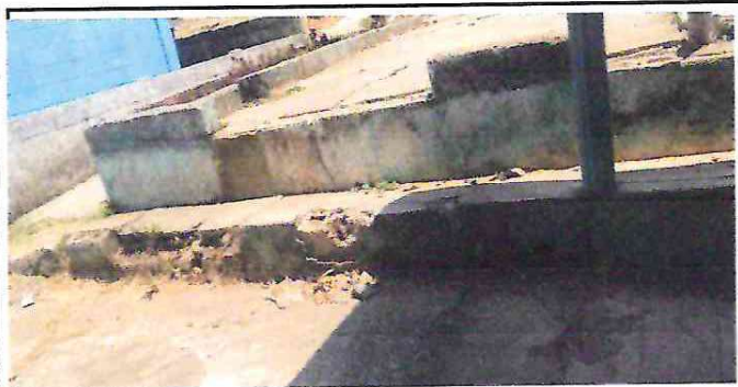
Foto 3: SUSTITUCION DE BANQUETA DE CONCRETO
